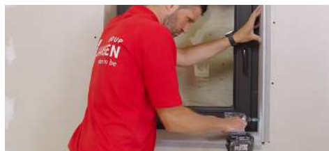
► ÉTAPE 4 appliquer du plâtre de collage, des vis ou coller
