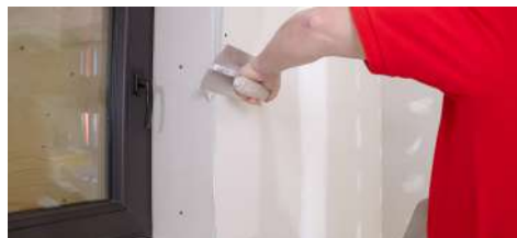
► STAP 5 afwerken van aansluitende muren
